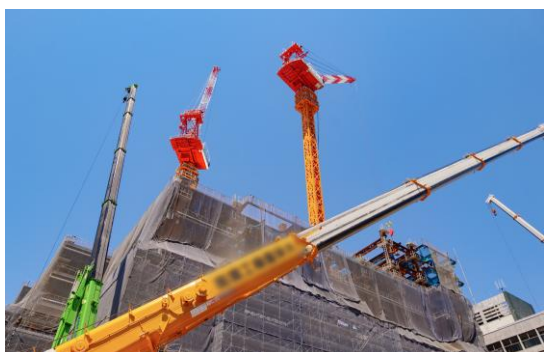
タワークレーンの昇降フレーム踊り場にカメラを設置し、吊り荷の下方エリアを撮影
