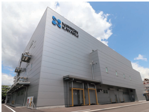
①産業用インクジェット製造設備
