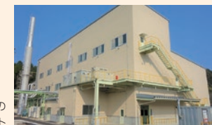
厚狹工場の 触媒製造用プラント
