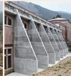
控え壁による補強
