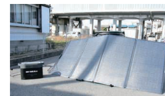
ポータブル電源(左)と折畳式ソーラーパネル
