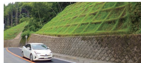
GTフレーム工法®によるのり面
