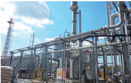
水島工場 水素ボイラー設備
