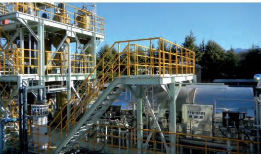
温室効果ガスの除害設備
