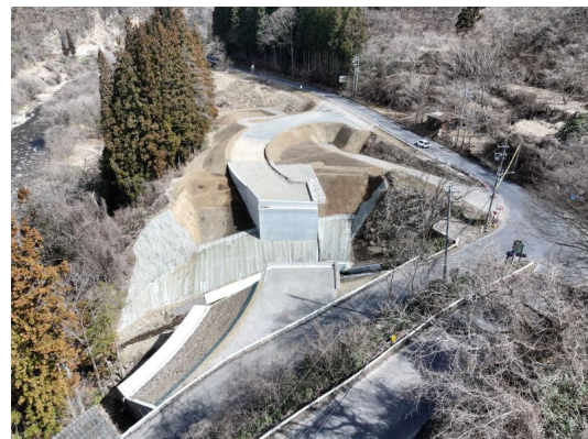
道路改良工事
