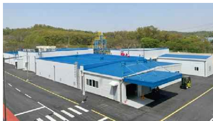
本格稼働した韓国CO設備
