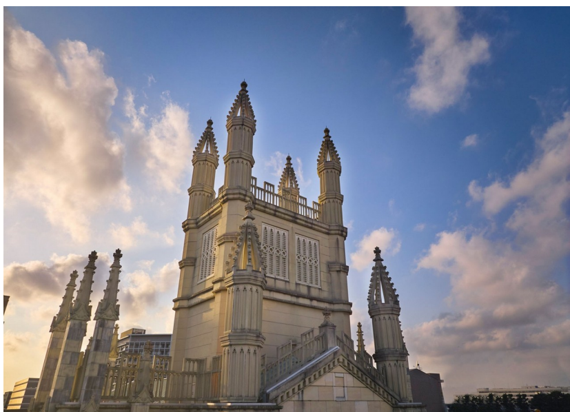
アビー・チャーチ 外観
