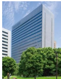
川崎テックセンター（一部専有部及び共用部） （報告期間内実施）
