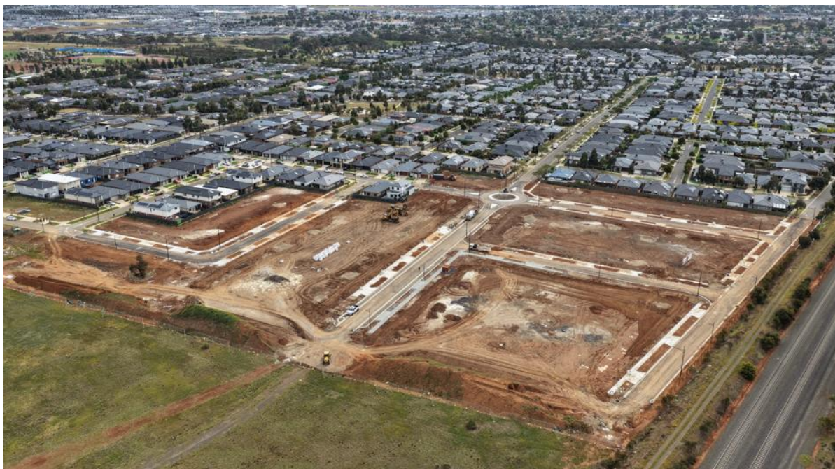
<Muncorp5号_Cobblebankプロジェクト>
