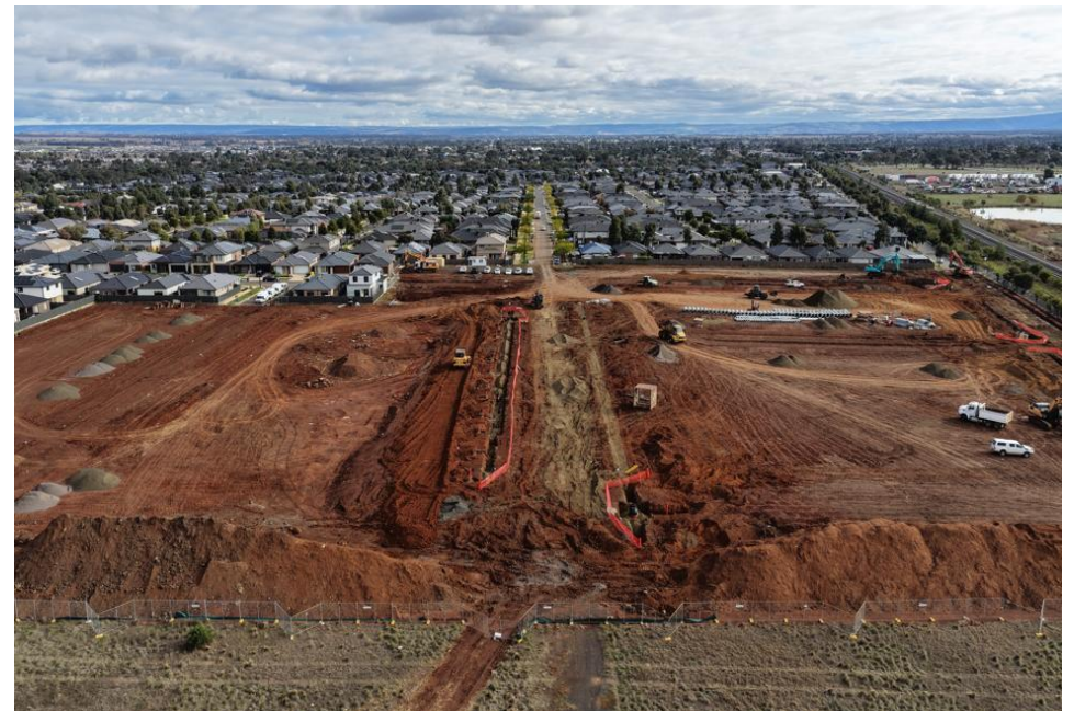
< Muncorp5号_Cobblebankプロジェクト>
