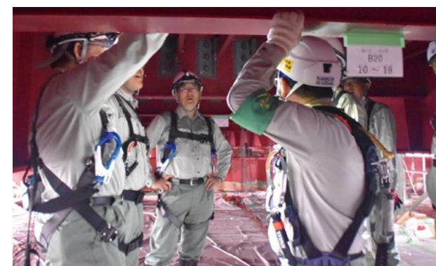
狭隘な橋梁建設現場のパトロール
