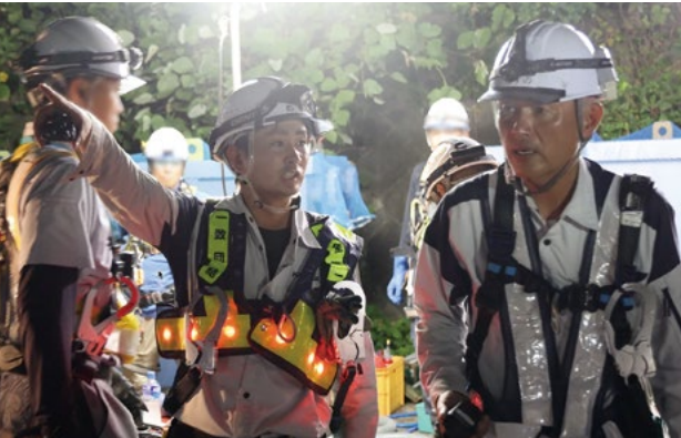
杉谷第2跨道橋撤去工事
