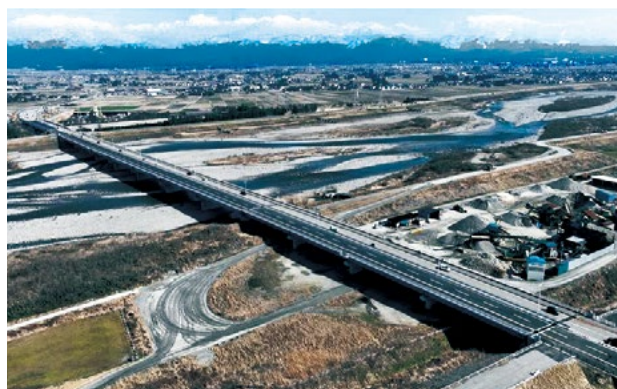
富立大橋(令和6年度 富山県建設優良工事表彰 土木部 知事賞受賞)
