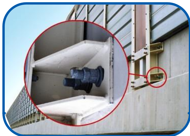
高速道路の防音壁に・・
