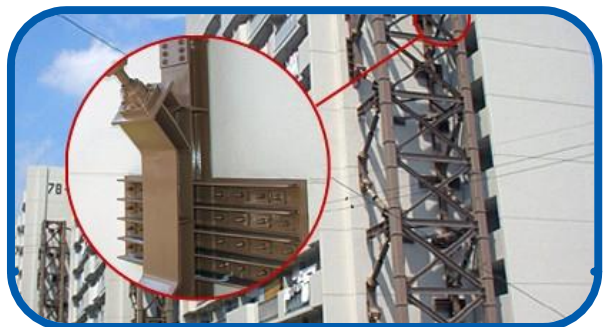
建物の耐震補強に・・
