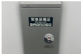
防災備品の設置
