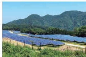
リエネ白石太陽光発電所(宮城県白石市)
