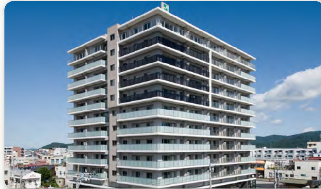
デュオヒルズ石巻マークス(2020年竣工)
