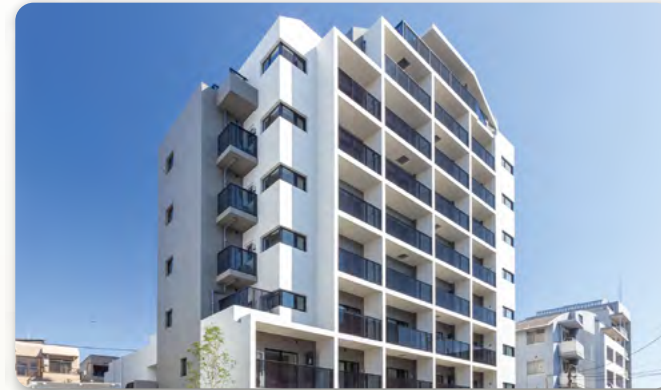
デュオフラッツ篠崎(2025年竣工)
