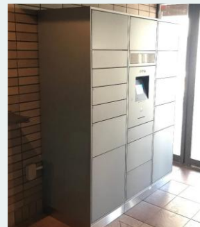
宅配ボックスの増設
