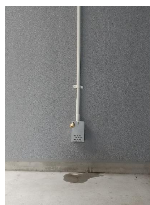
浸水センサーの設置
