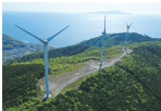
風力発電所（静岡県東伊豆町）
