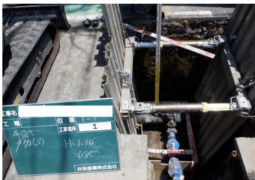
【水道管布設工事】
