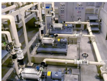
【給排水衛生設備工事】
