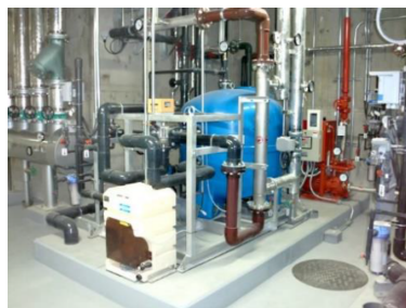
【給排水衛生設備工事】
