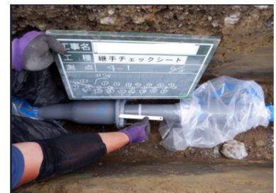
【水道管布設工事】
