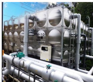
【給排水衛生設備工事】
