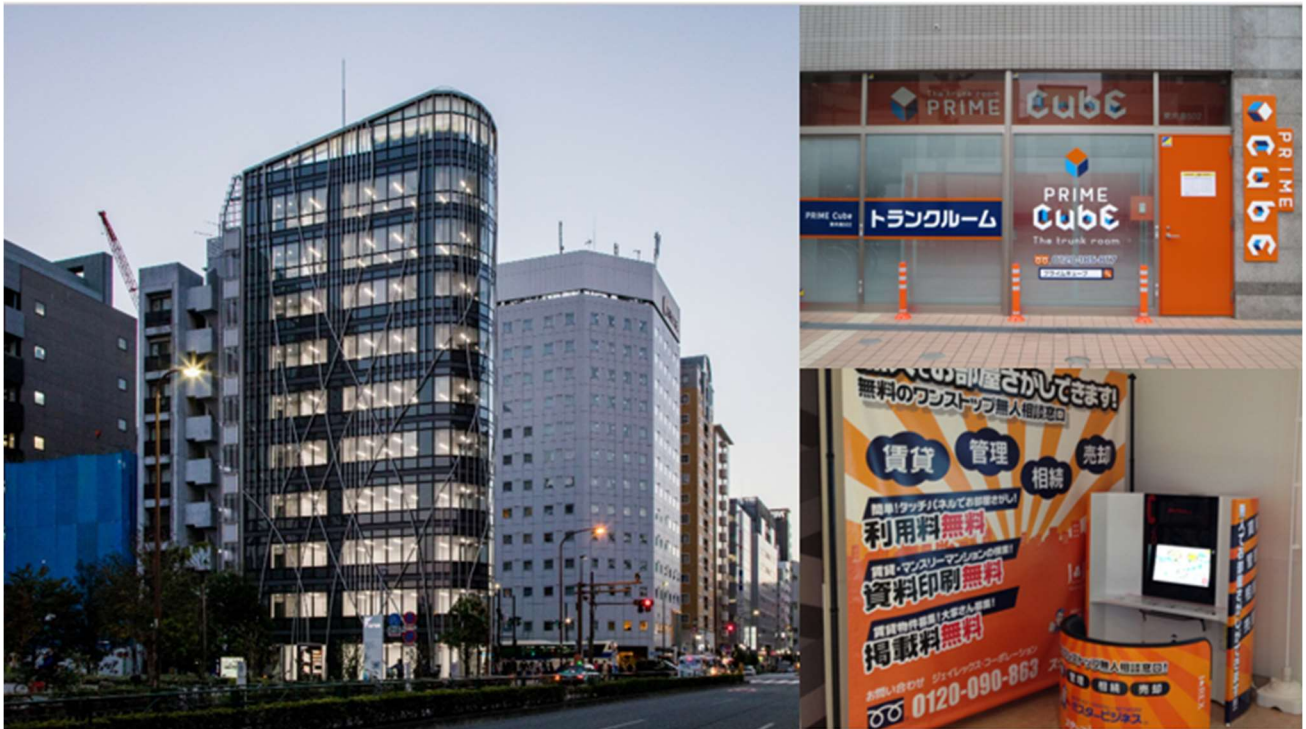
左 新宿イーストクロスタワー（丹下都市建築設計のデザイン、当社開発によるテナントビル）
