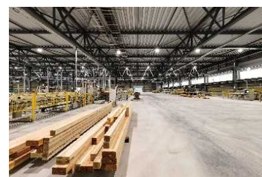
プレカット事業部 茨城工場 工場内
