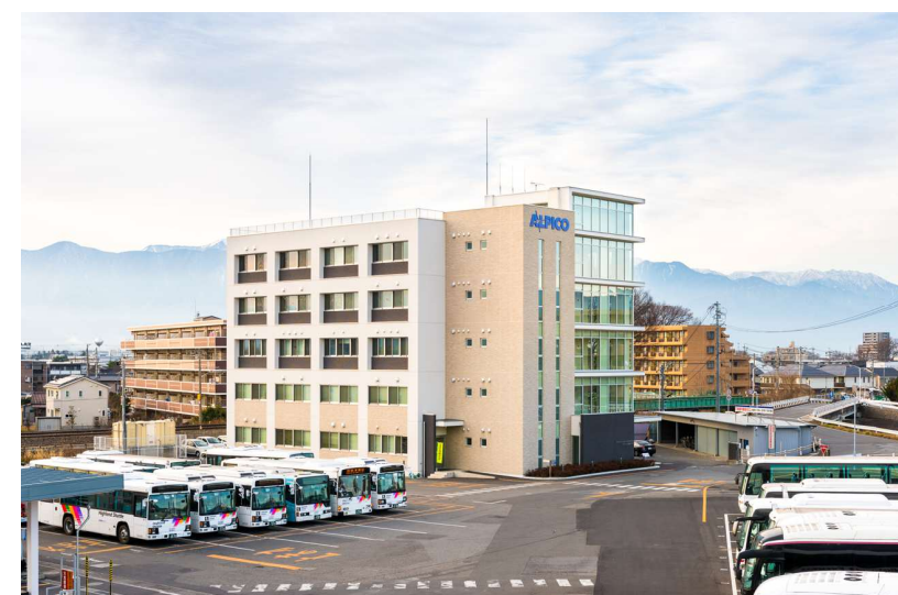
アルピコホールディングス本社社屋（松本市）
