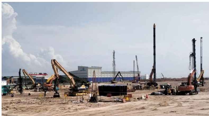
本プラント建設現場の様子（2025 年 6 月）
