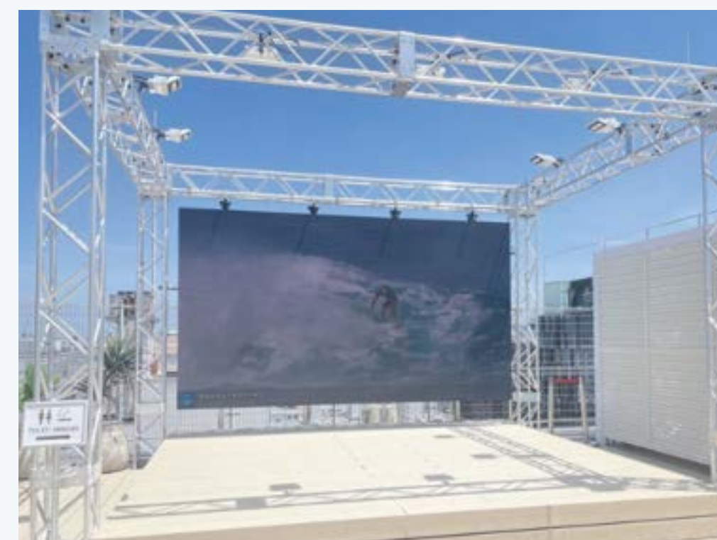
商業施設外構工事
