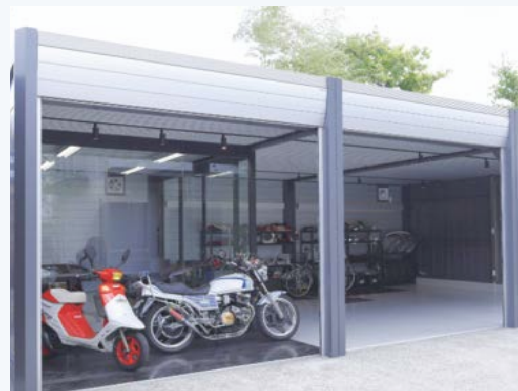
一般戸建外構工事（ガレージ施工）
