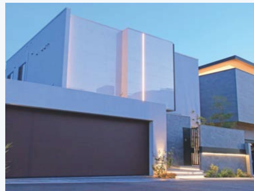
一般戸建外構工事
