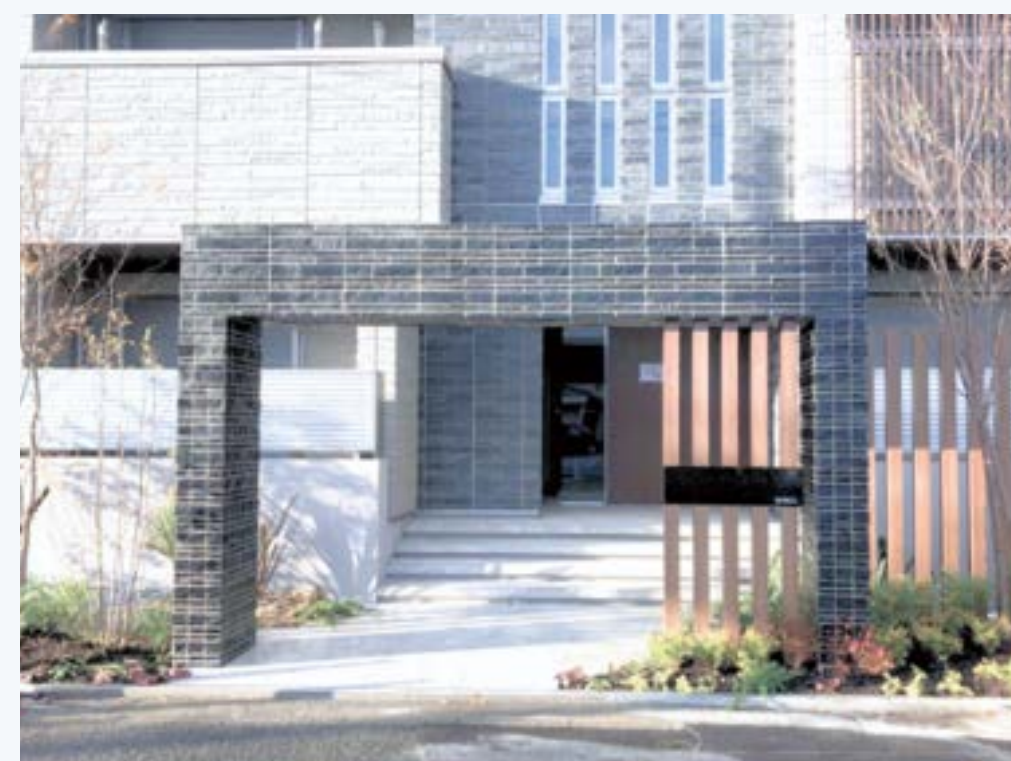
集合住宅外構工事
