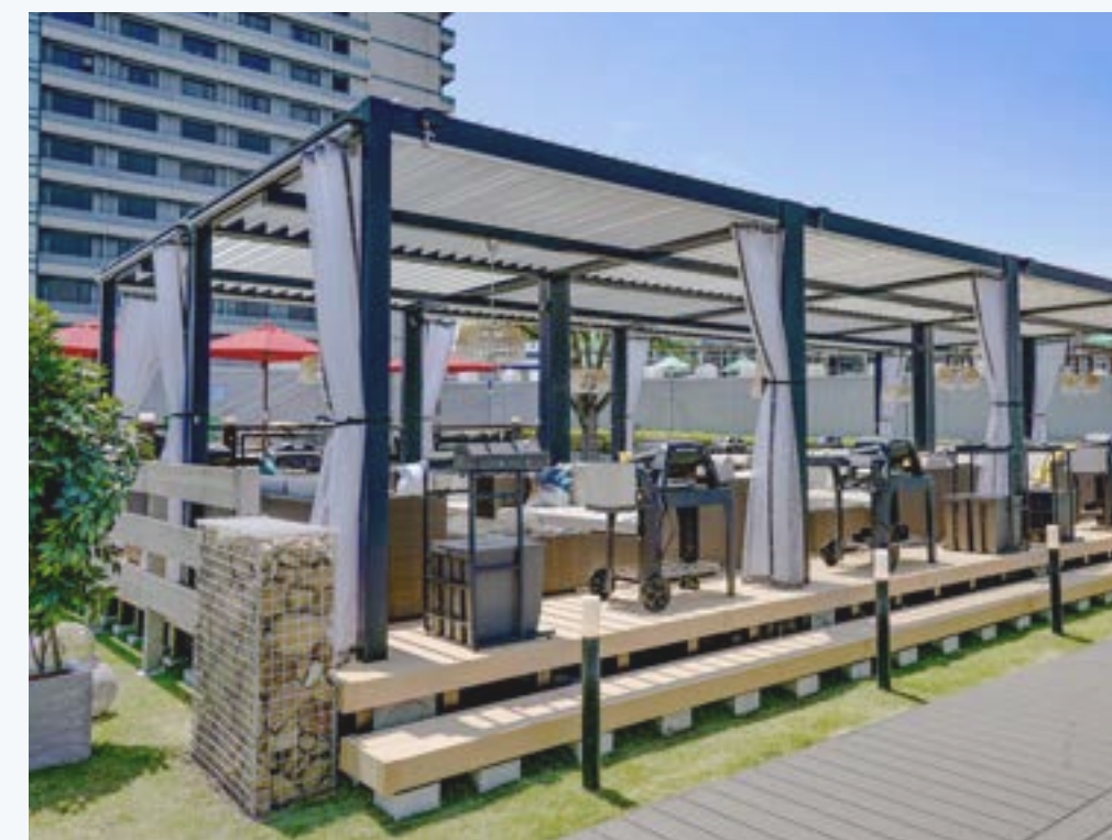
商業施設外構工事
