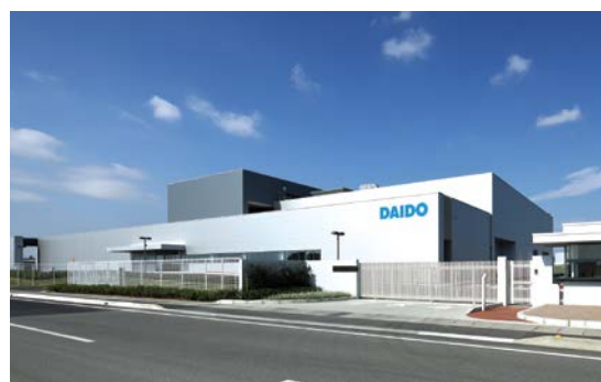
新たに建設した大同薬品工業の関東工場
