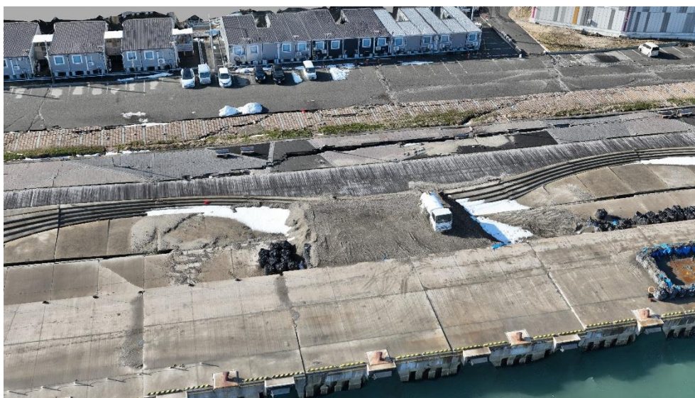
ドローンの撮影写真から生成した 3D データの様子①
