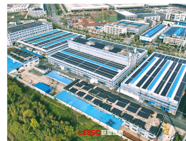
太陽光パネル設置事例
