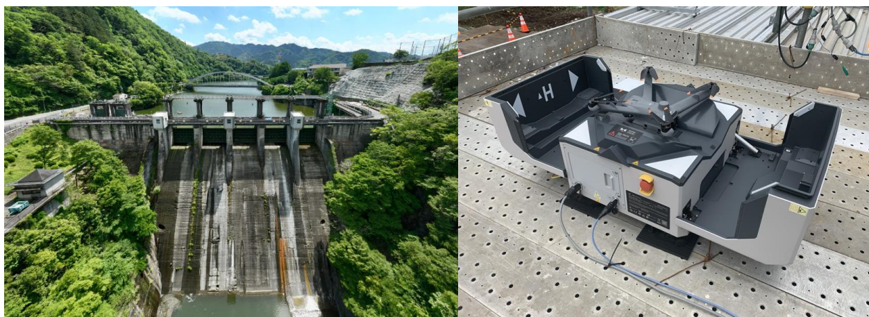
相模ダム全体の空撮写真と設置した自動充電ポート付きドローン
