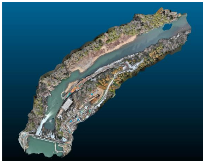
自動生成された現場全体の点群データ
