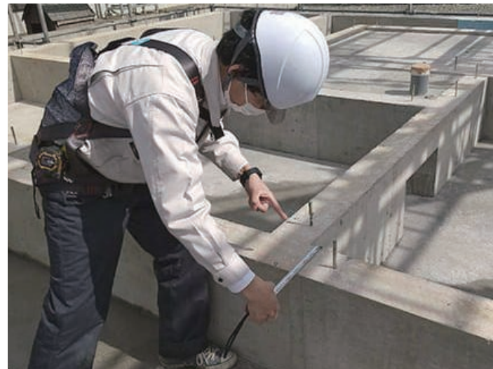
現場での検査の様子
