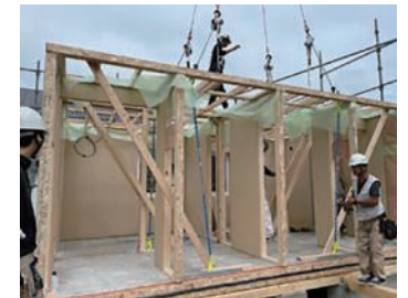
搬送されたモジュールは現場でクレーンを使って組み立てる
