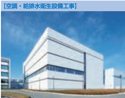
中外製薬株式会社 宇都宮工場 無菌注射剤製造棟 (UTA) (栃木県)
