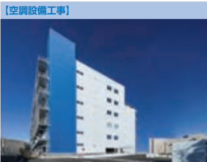
NRT12 データセンター実装 (千葉県)
