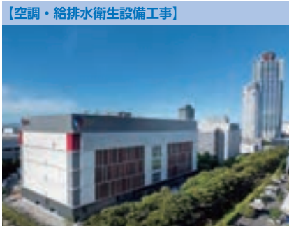
ESR南港OS1 データセンター (FO-1) (大阪府)
