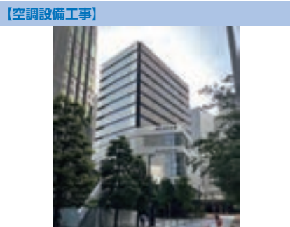
新日本消防会館 (東京都)
