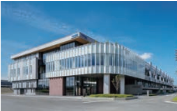
大阪ガス株式会社 Daigas Innovation Center 用途：事務所、工場など、規模：15,969㎡、地上4階 ZEBランク：ZEB Ready
