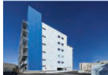
NRT12 データセンター実装 (千葉県)
