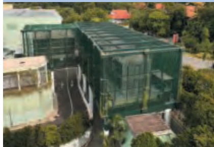
リゾートワールドセントーサ第2地冷設備機械室 (シンガポール)
