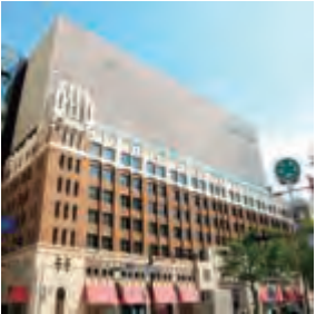
2019年 大丸心斎橋店本館
