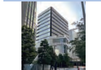
新日本消防会館 (東京都)
