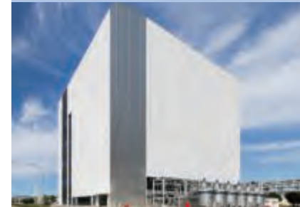
中外製薬工業株式会社 後期開発及び初期生産用合成原薬製造棟(FJ3) (静岡県)
