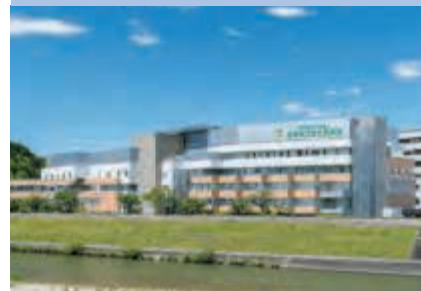
岐阜県立多治見病院 (岐阜県)
