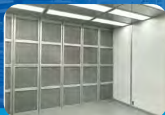
高砂層流式クリーンルーム
