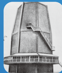
国産第一号の冷却塔
