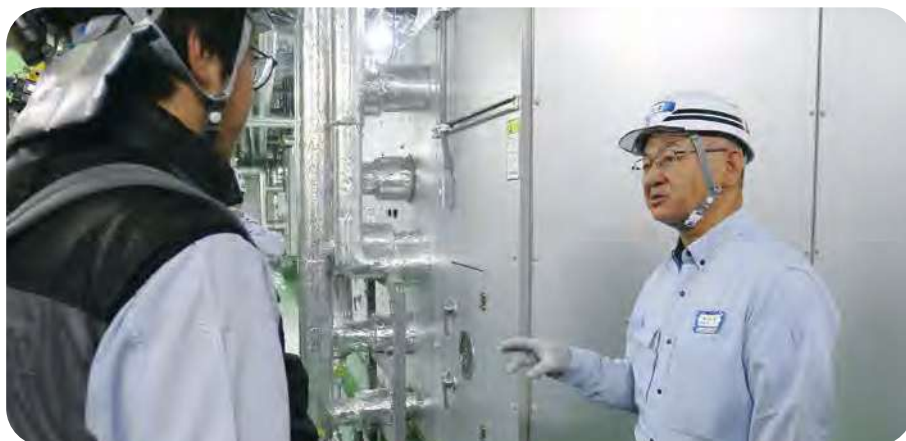
社長による現場安全パトロール
