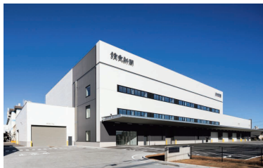
川越プロジェクト (印刷棟) 新築工事
