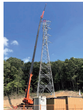
東北電力ネットワーク(株) 西白河変電所引出供給線新設工事
