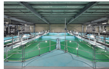
RKB陸上養殖新築工事
