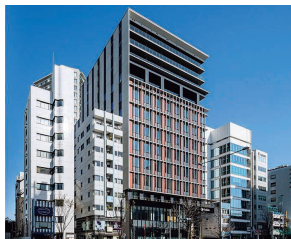
青朋ビル（北青山三丁目） 基礎整備・建設工事
