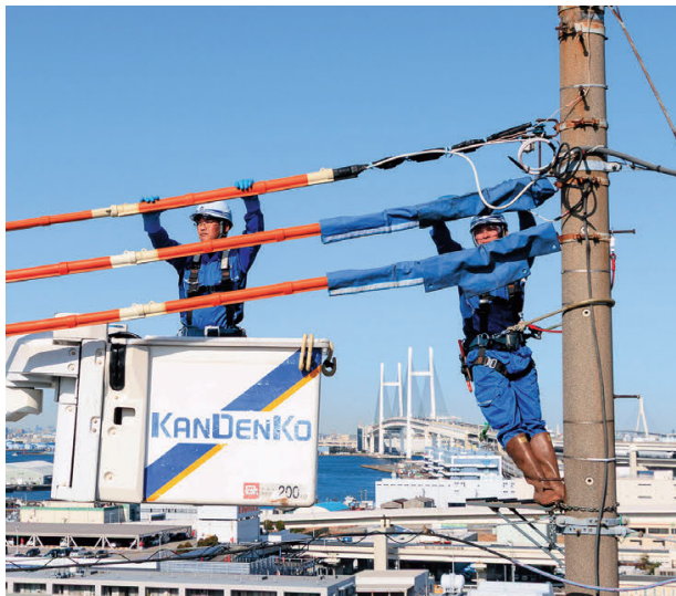
本線設備強化改修工事（神奈川県）
