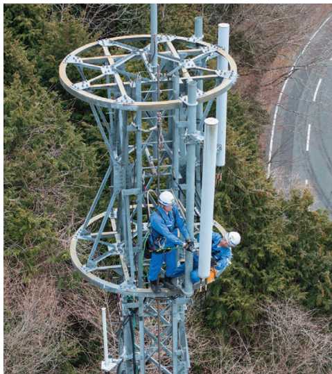
無線通信アンテナ設置工事（茨城県）
