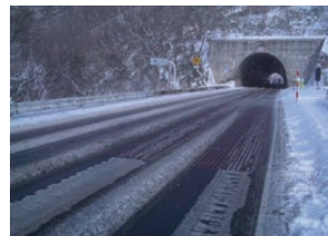
凍結抑制舗装(ザベック工法タイプG)
