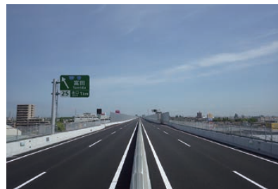
①アスファルト舗装工事
