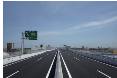
①アスファルト舗装工事
