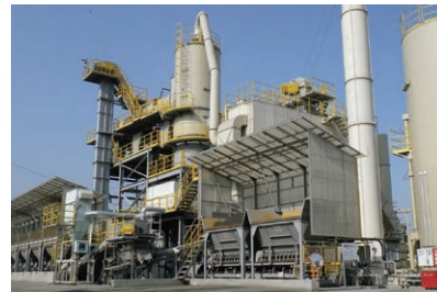
②アスファルト合材工場
