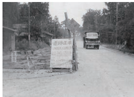
会社設立当時の舗装工事
