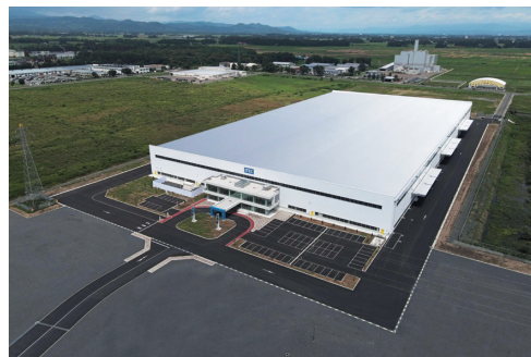
(仮称) (株)アイ・テック北上工場新築工事
