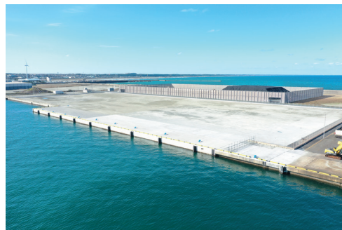
令和5年度 鹿島港外港地区岸壁(-12m) 上部他工事
