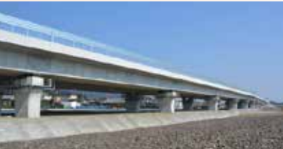
新名神高速道路鈴鹿高架橋工事(三重県2019) ▶「CSR REPORT 2018」に工事の詳細を掲載
