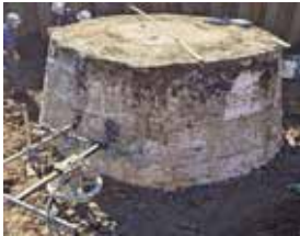
newACE工法掘り出し調査試験
