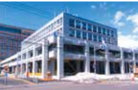
釧路市庁舎(北海道2009)【PC工事】 外壁にPCaPCの頑丈なコンクリート枠を取り付ける工法。建築内部の工事がほぼ不要で騒音も非常に低いため工事中の施設利用が可能
