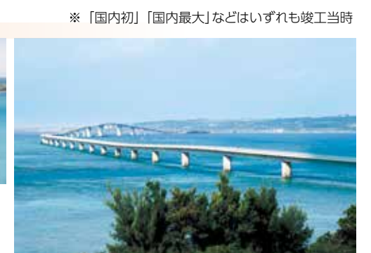
伊良部大橋（沖縄県2006-2015）
