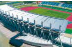
三重交通Gスポーツの杜 伊勢陸上競技場(三重県2017)【PC工事】 国体のメイン会場。日本家屋伝統の「架構美」をコンクリートの直線部材で表現
