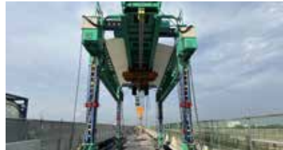
プレキャストPC床版用移動敷設クレーン
