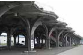
青苗漁港(北海道2000)【PC工事】 荷捌き場と津波避難施設を兼ねた人工地盤
