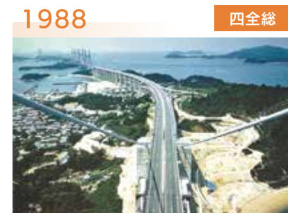
1988 四全総 本州四国連絡橋児島坂出ルート・櫃石島高架橋（香川県） 当社をスポンサーとする国内初のPC專業企業JVでの施工。道路上下線と鉄道を1台で施工でき、道路幅の変化に応じて横移動も可能な大型移動支保工（サポートタイプ）を開発
