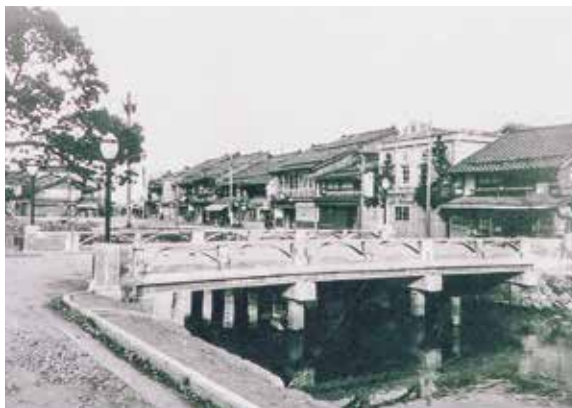
国内初のPC橋 長生橋 （石川県1952.2）
