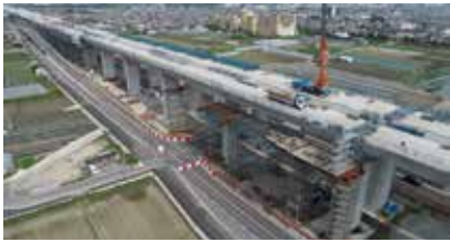
城陽第二高架橋東工事
