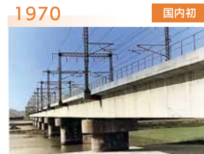
1970 国内初 山陽新幹線加古川橋梁（兵庫県） 鉄道橋に国内初のプレキャストカンチレバー工法を採用
