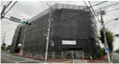
ビル大規模修繕工事
