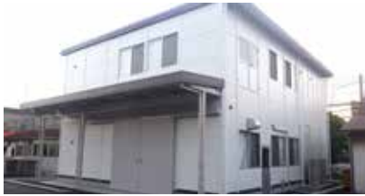
PSC水島工場新試験室増築工事
