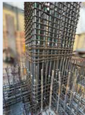
基礎パネルゾーン配筋納まり
