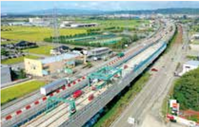
北陸自動車道金沢高架橋(石川県2029) 老朽化と塩害で劣化が進む北陸道の床版取替工事に、独自開発の「低空頭タイプ床版架設機」を導入
