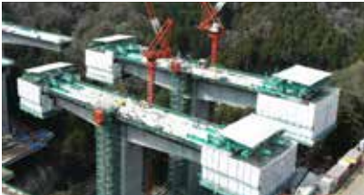
片持架設移動作業車(尺里川橋)
