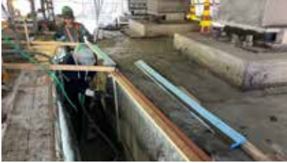
薩埵高架橋/施工状況
