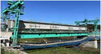
架設桁(梯川橋梁)
