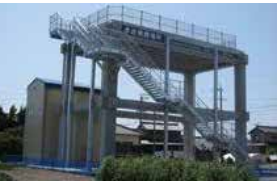
掛川市津波避難施設(静岡県2012)【PC工事】 国内初のPCaPC津波避難施設
