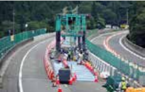
中国自動車道谷第二橋(山口県2017) NEXCO総研との共同開発。PC床版を半断面単位で取り替えることで交通規制による渋滞等の社会的影響を軽減
