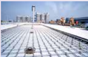
(土木)羽田空港リフトアップ工事(東京都1993) 総面積約37万㎡のPC舗装工事
