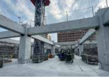
福岡中央病院建替工事(福岡県2025) PCaPC部材の「梁」と「柱」を組み合わせで大空間を構築
