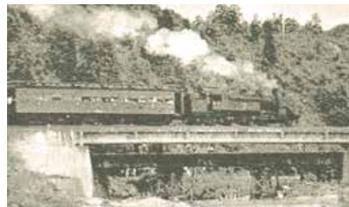
信楽高原鉄道第一大戸川橋梁 （滋賀県1954） 国内初の本格的なPC鉄道橋。2021年、国の重要文化財に登録
