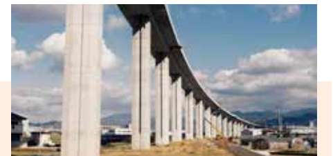
四国縦貫自動車道重信川高架橋（愛媛県1996）
