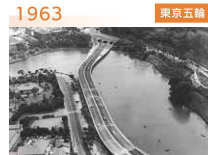
1963 東京五輪 首都高速道路4号線千鳥ヶ淵高架橋（東京都） 走行の安全性を高める滑らかなカーブ（クロノイド曲線）を実現
