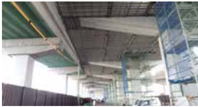
阪神高速池田線大規模修繕工事
