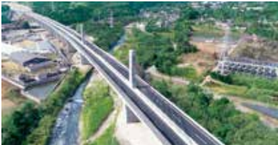
新名神高速道路菟野第二高架橋工事(三重県2019) 国内最大規模のPRC3径間連続エクストラード橋 ▶「CSR REPORT 2019」に工事の詳細を掲載
