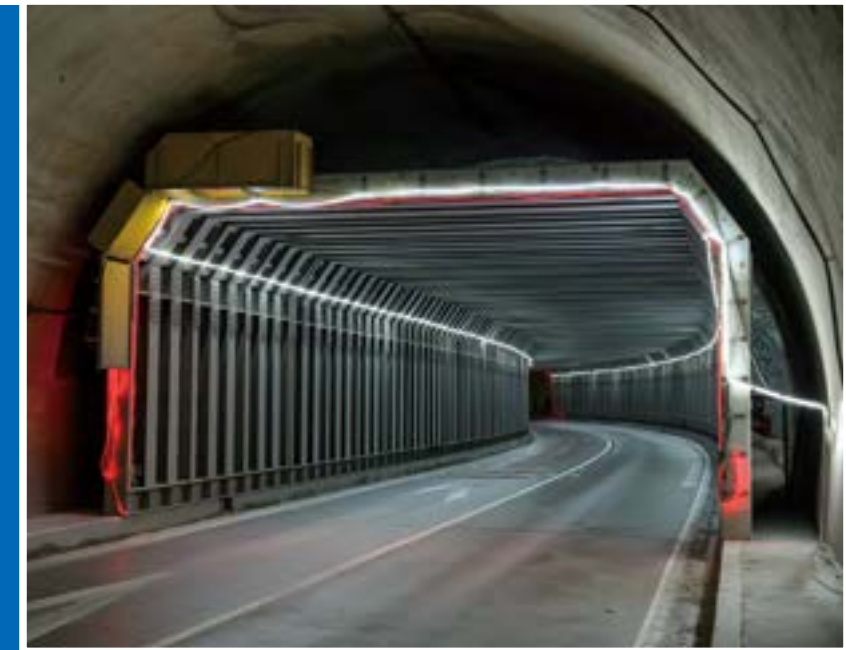
既設トンネル補強のため鋼製プロテクターを設置
