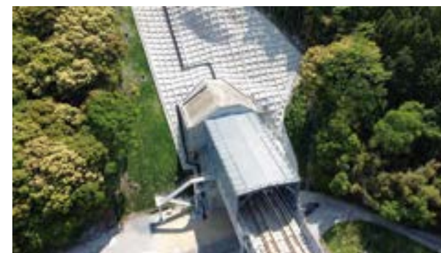
九州新幹線(西九州)、17k5・44k2間線路諸設備他 発注者:(独)鉄道建設・運輸施設整備支援機構 九州新幹線建設局
