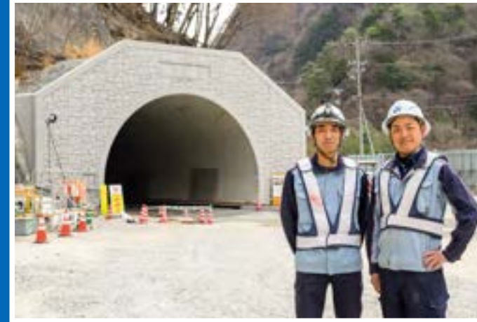
現場の若手社員(トンネル坑口)
