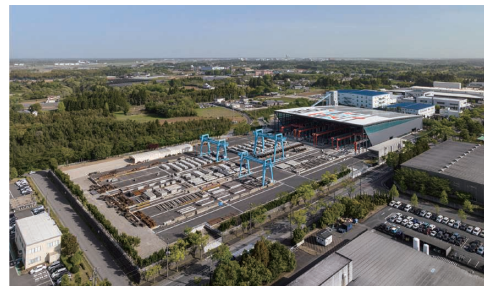
工場棟外観（航空写真）
