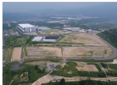
南海橋本林間田園都市第三一3（1工区）宅地造成工事
