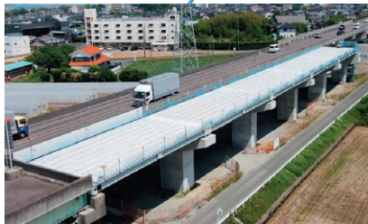
大清水高架橋B1 (愛知県豊橋市)
