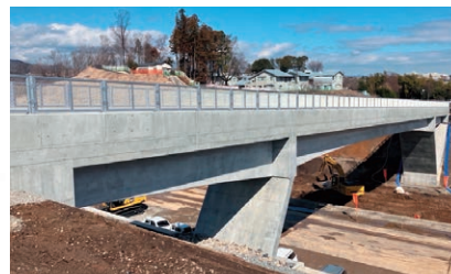
寺田跨道橋 (東京都八王子市)
