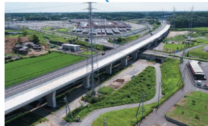
阿見高架橋 (茨城県稲敷郡阿見町)
