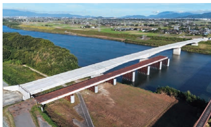
両筑橋 (福岡県久留米市)
