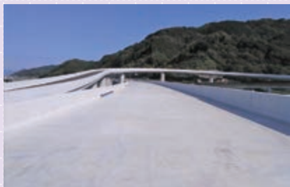
五台山第5高架橋 (高知県高知市)
