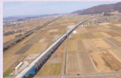
第2三ツ屋橋りょう (福井県越前市)
