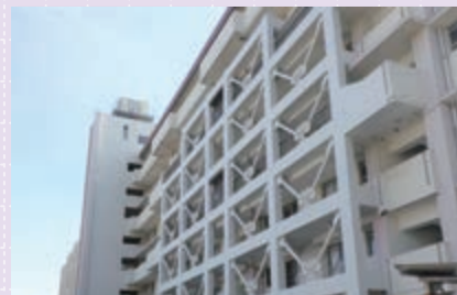
市営福浜住宅4棟耐震等改修
