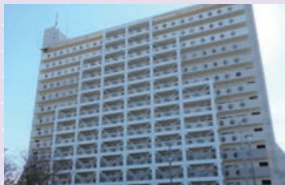
公社槇塚台団地耐震改修
