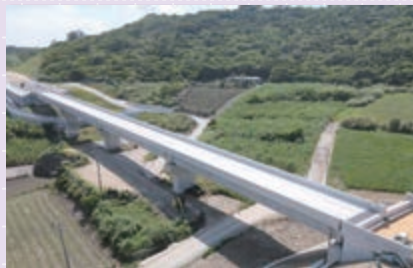
大城高架橋 (沖縄県南城市)
