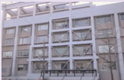
三条庁舎耐震改修
