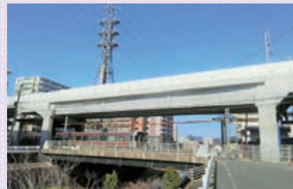
西鉄高架連立事業 (福岡県福岡市・春日市・大野城市)
