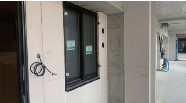
非耐力壁ALC工法
