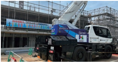
現場で採用した電動式ラフテレーンクレーン
