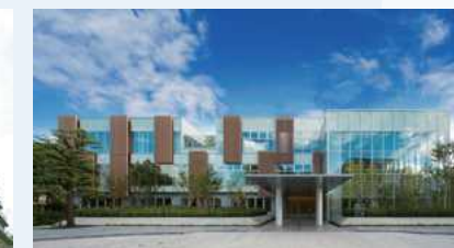
創業80周年PJにて新設「長谷工テクニカルセンター・長谷工マンションミュージアム」
