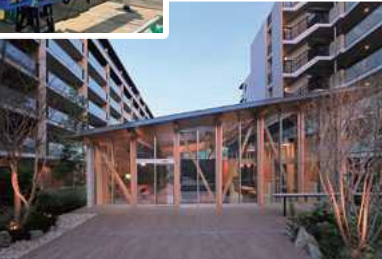
木造共用棟の建設「ルネ横浜戸塚」
