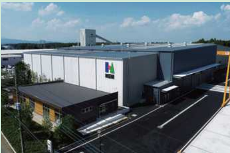
プレキャストコンクリート(PCa)工場
