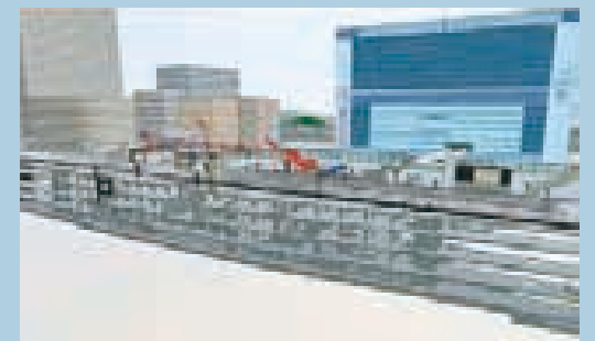
駅舎全体を内製でBIMモデル化
