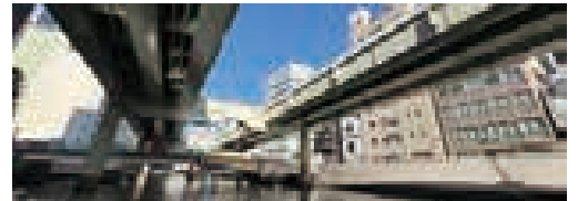
橋桁・橋脚撤去完了状況
