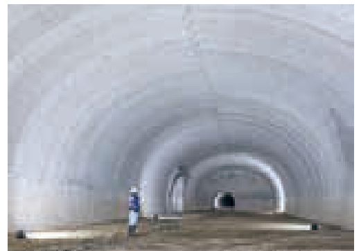
国内最大級のプレキャスト覆工 (中間ポンプ室) (熊本県阿蘇市)
