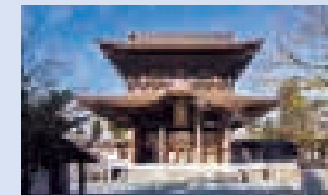
2023 阿蘇神社楼門保存修理 2016年の熊本地震で全倒壊した楼門を復元。部材を可能な限り補修のうえ再利用した
