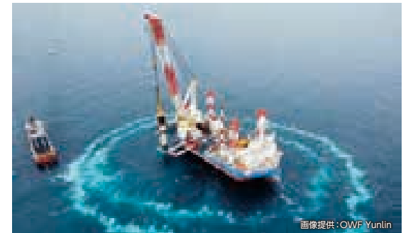
雲林沖洋上風力発電所建設工事（備船）のバブルカーテン（台湾） 画像提供：OWF Yunlin
