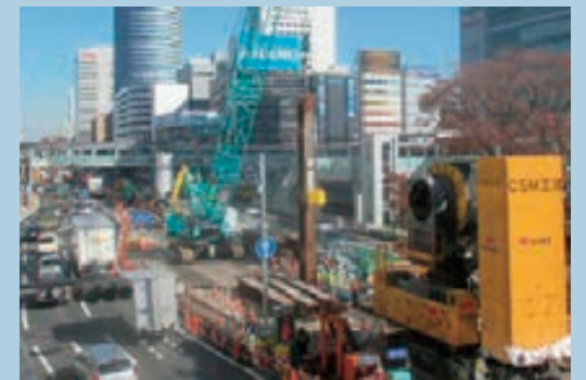
環状2号線上で鋼製地中連続壁の部材を建て込み
