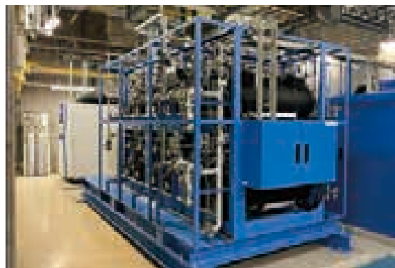
Hydro Q-BiC水素吸蔵合金タンク (東京都 東京臨海熱供給(株) 青海南プラント内)
