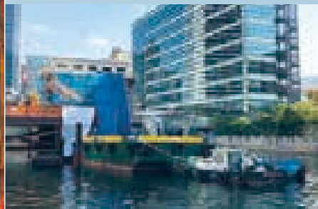
仮設栈橋を利用し、建設発生土を海上運搬
