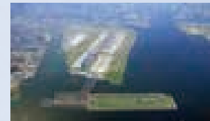
2010 東京国際空港D滑走路 世界でも珍しい埋立と栈橋のハイブリッド構造を採用した大規模海上滑走路 (画像提供:羽田再拡張D滑走路JV)
