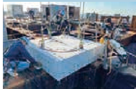
鉄骨上にPC化した免震基礎上部を設置
