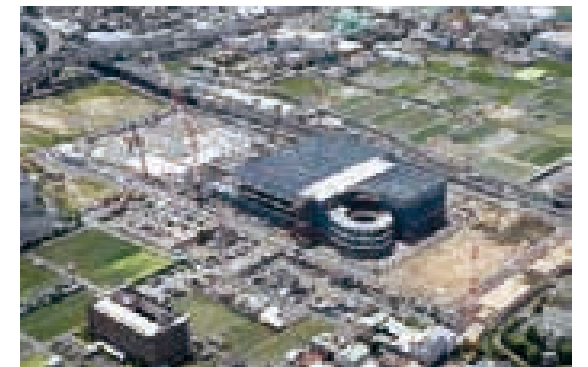
S・LOGI松原 (大阪府松原市) 建設現場 ※ 記載の情報は掲載時点のものであり、計画が変更になる場合がございます。 | 今後の予定 竣工：2026年5月
