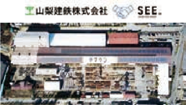
山梨建鉄の工場に設置された太陽光発電設備
