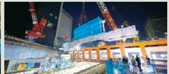
自由通路工事での線路上における桁架設状況
