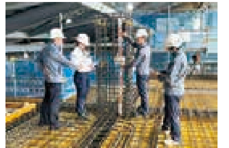
モックアップを利用した配筋検査実習
