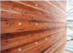
組み上げられた型枠杉板の加工
