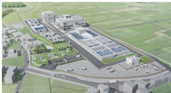
甲山浄水場更新事業 新浄水場建設事業 (兵庫県姫路市) 発注者：姫路市
