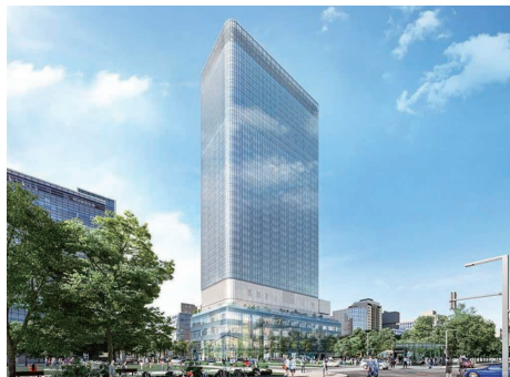
大通西4南地区第一種市街地再開発事業の内、 施設建築物等新築工事 (北海道札幌市) 発注者：大通西4南地区市街地再開発組合
