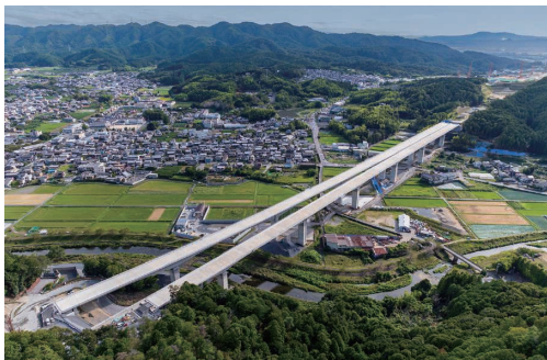
新名神高速道路 宇治田原第二高架橋(PC上部工) 工事 (京都府綴喜郡) 発注者: 西日本高速道路株式会社
