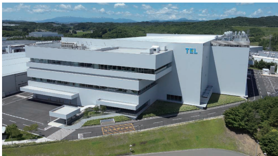
東京エレクトロン宮城株式会社 第3開発棟新築工事 (宮城県黒川郡) 発注者: 東京エレクトロン宮城株式会社
