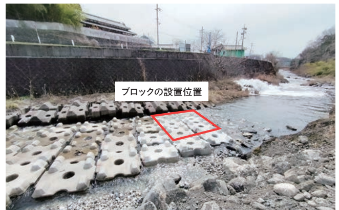
姉川に設置した根固めブロック
