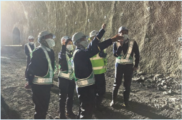
山岳トンネル現場での視察状況
