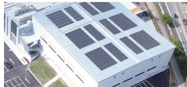
葦崎中央体育館
